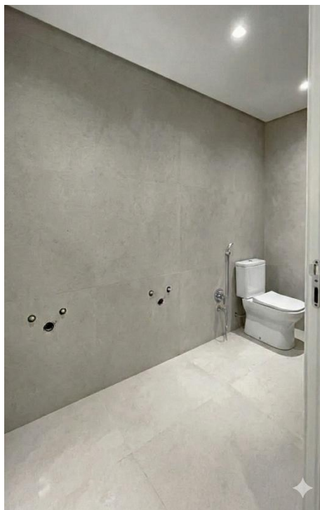
Figura 5: Revestimento em Parede e Piso do mesmo tamanho com harmonização de cores, previamente aprovado pela fiscalização
