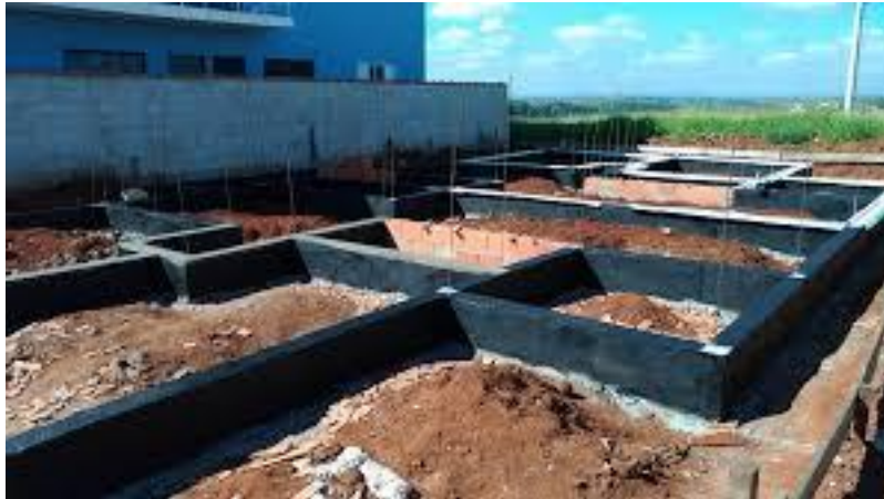
Figura 3: Aplicação de impermeabilização em Baldrame
