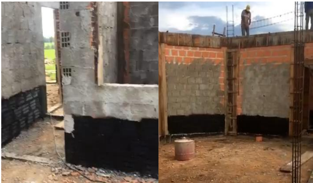
Figura 4: Aplicação de impermeabilização
